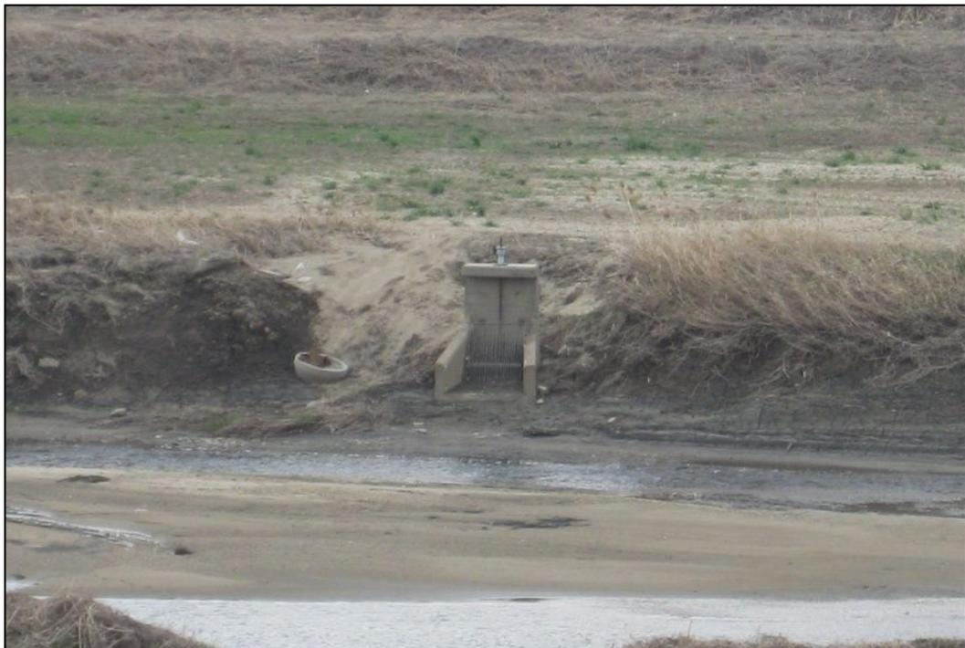
[그림 4-57] 유구천 3지점 역행침식 및 취수시설 노출 전경
