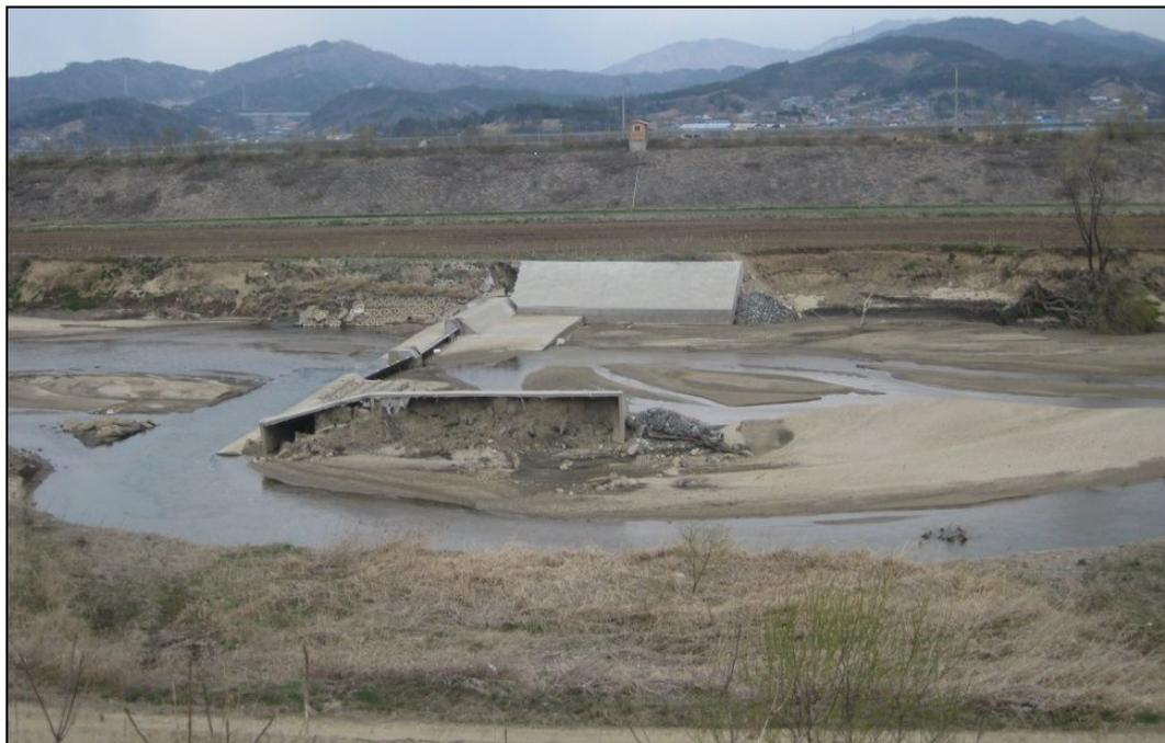
[그림 4-55] 유구천 1지점 역행침식 및 보 붕괴 전경
