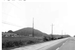
중점관리구역 대상지 전경 2
