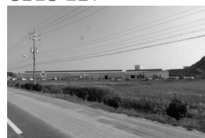
중점관리구역 대상지 전경 3
