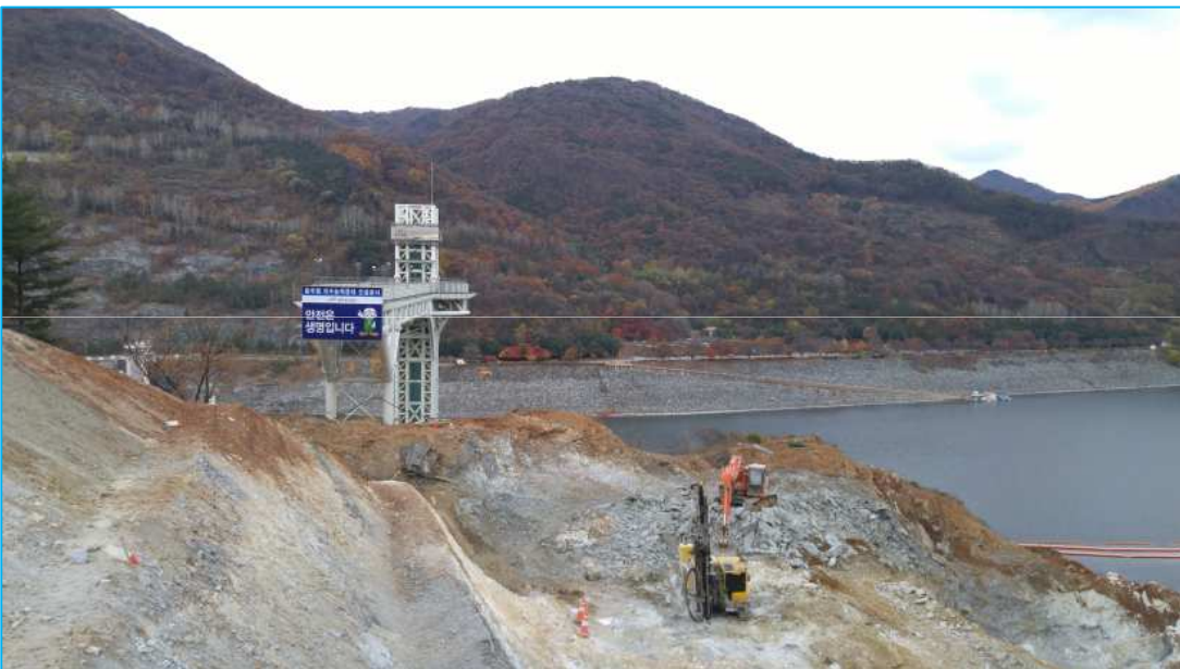
<2015년 11월 충주댐 치수능력증대 공사 현장>
