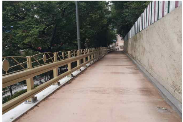
토성둘레길 황토콘크리트 포장
