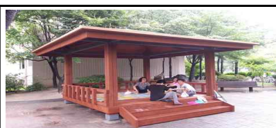
주민공동시설 보수 (월평주공2)
