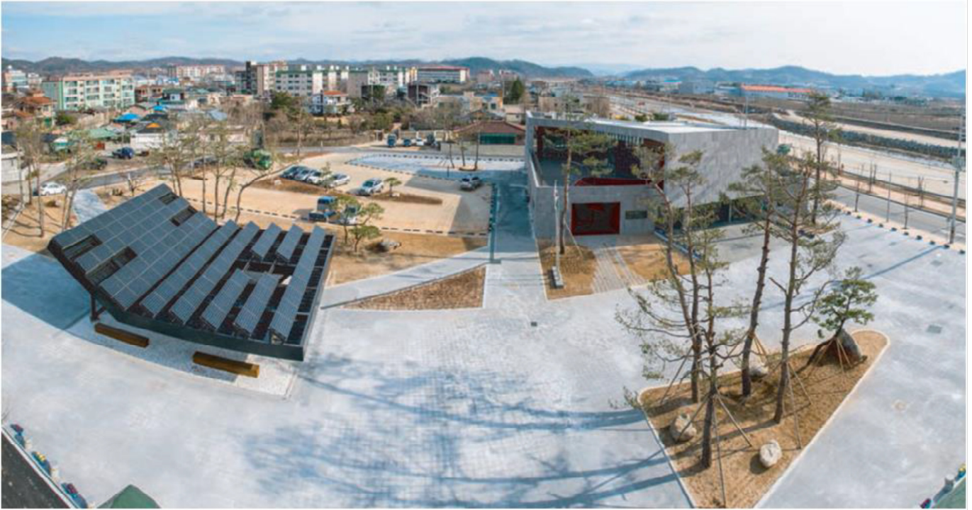
광장에 태양광 발전소(30KW)를 처음부터 디자인 요소화하여 광장과 일체화했으며 랜드마크적인 역할
