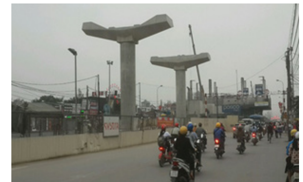
하노이 시내에 건설 중인 도시철도.우리나라의 주요 건설회사가 시공중이다.
