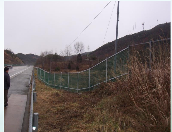
생태통로 및 펜스 설치
