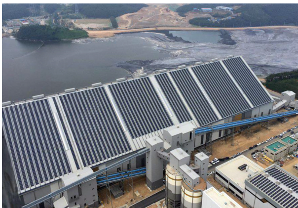
[그림 6-2] 신보령과 태안화력발전소의 옥내 저탄장 모습
