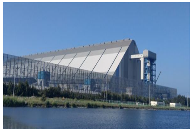
[그림 6-2] 신보령과 태안화력발전소의 옥내 저탄장 모습
