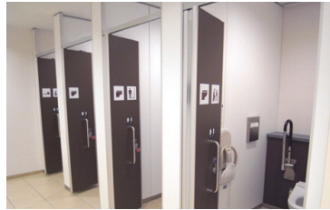
▲ 이동식 화장실 내부에 안전 손잡이를 설치하여 편의를 증진시킨 사례
