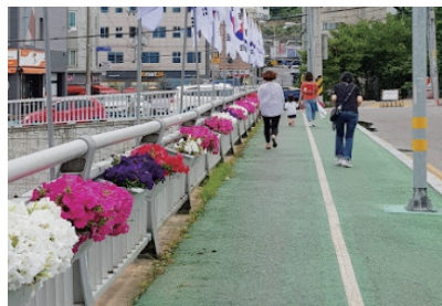
▲ 보도 폭이 좁은 경우, 다른 지주 시설물을 이용하여 통합 설치한 사례
