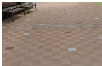
▲ 경사면에 미끄럼 방지 블록을 설치한 사례
