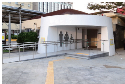
▲ 화장실 진입 경사로에 안전손잡이를 설치하여 접근성을 높인 사례
