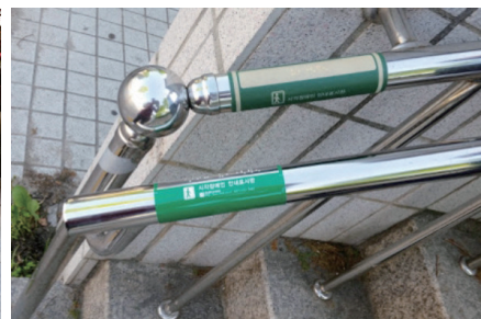
▲ 양끝부분 및 굴절부분에 점자표지판을 부착하여 시각장애인이 쉽게 인식할 수 있게 한 사례
