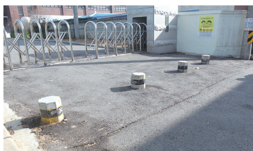
낮은 석재 볼라드로 차량 파손 및 보행 위험 요소
