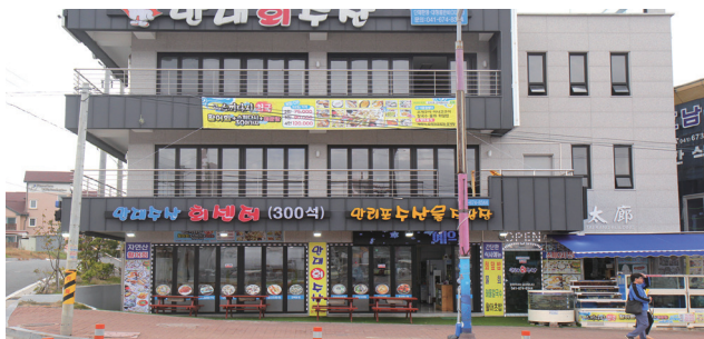
간판 용도의 현수막 설치
