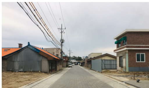
대지 남동측 1구역과 2구역 사이 진입로
