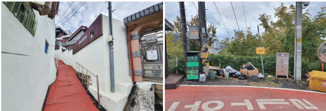
안전난간의 연속성 부재 및 소재의 부적절, 골목 곡각부분 안전성 대책 부재
