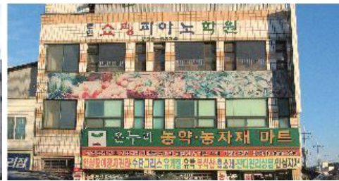
개방감 없는 건축물 (건축물의 특성을 고려하지 않은 설치)
