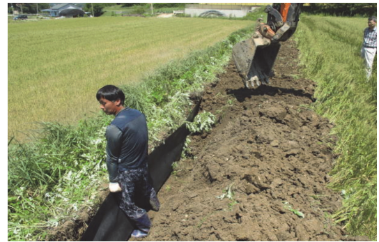
[그림 5-13] 논두렁 물막이판 설치 지원
