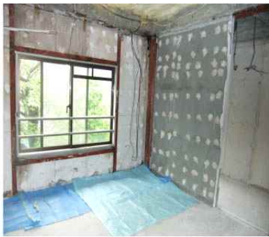
改修中の住戸
