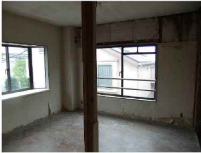
改修前の社宅の個室
