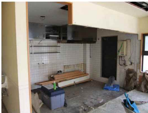
改修中のキッチン
