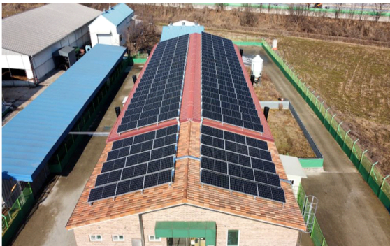
자료: 충북넷(23.01.16) 충북의돈사내 태양광발전 활용 사례
