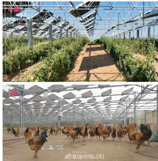
[그림 22] 내몽골 오르도스의 영농형 태양광시설
