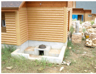
〈그림3-19〉 재래식 아궁이와 구들장벽난로 시스템
