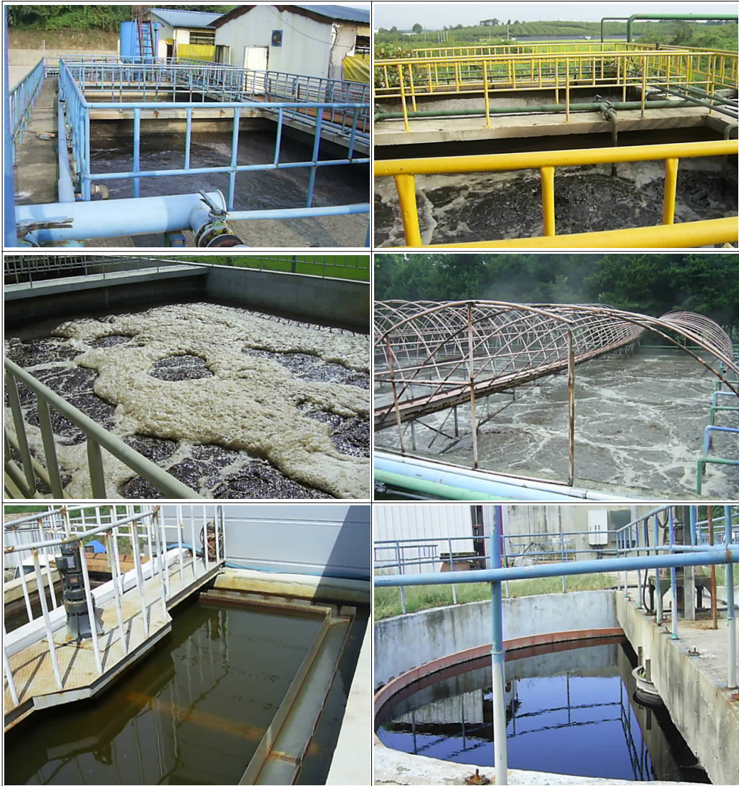
[그림 3-9] 정화처리시설 전경(포기조 및 침전조)
