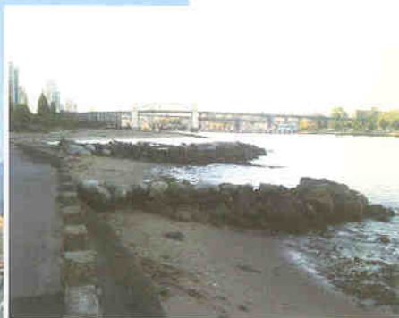
▲ 잉글리쉬 베이의 해안에 위치한 수제(水際). 이들은 바닷물의 운동에너지를 완충시켜 해안구조물 및 해수욕장 모래의 유실을 방지한다.
