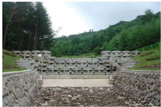
[그림 2-7] 구축재료에 따른 다양한 사방댐
