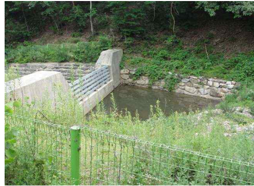
[그림 3-9] 국유림 내 설치된 사방댐
