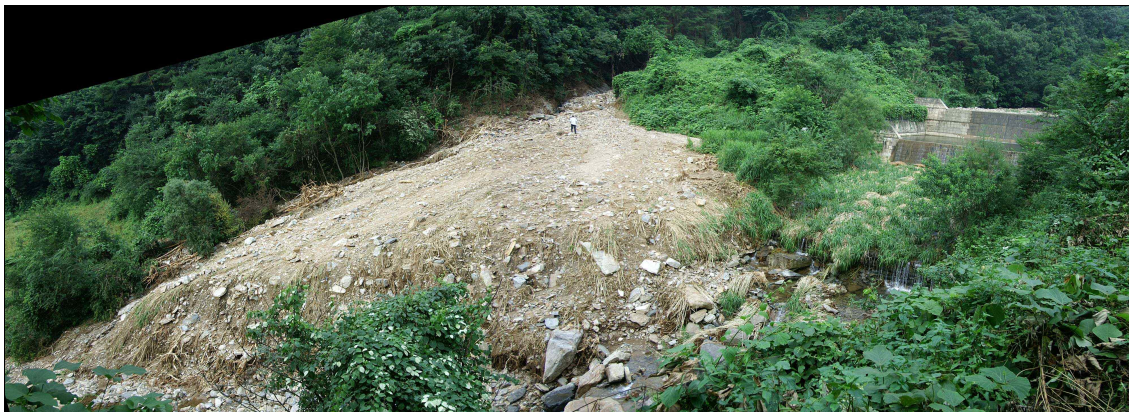
좌 : 사방댐 미설치구간 토사유출, 우 : 사방댐 설치구간 토사차단
