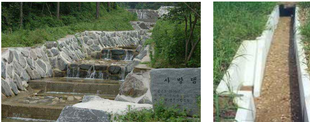
[그림 3-15] 야생동물 통로가 단절된 사방댐 및 탈출로가 조성된 측구
