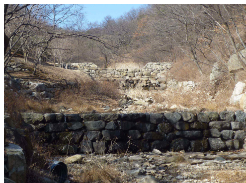
[그림 3-8] 주변 자연석을 이용한 사방댐과 바닥 암반을 보존한 사방댐
