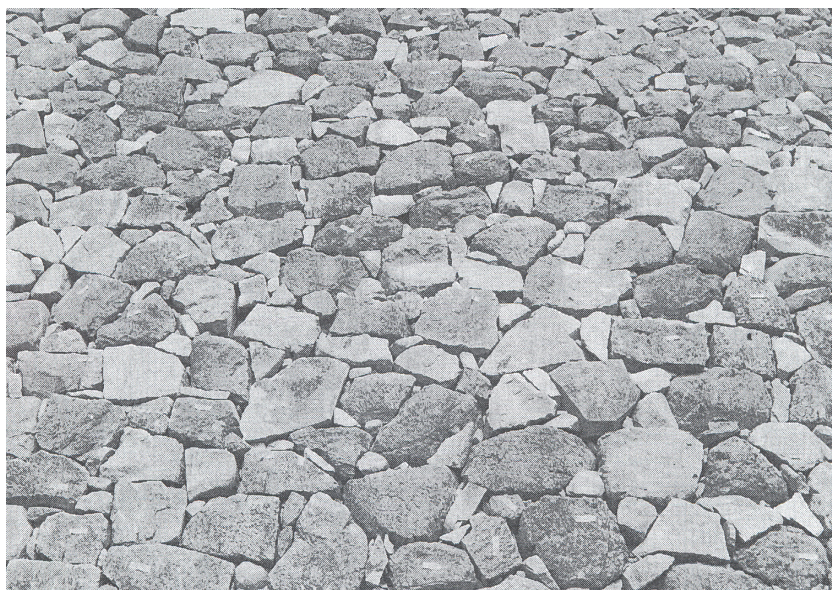
<사진12> 성벽의 신석재와 기존석재의 사용 모습
