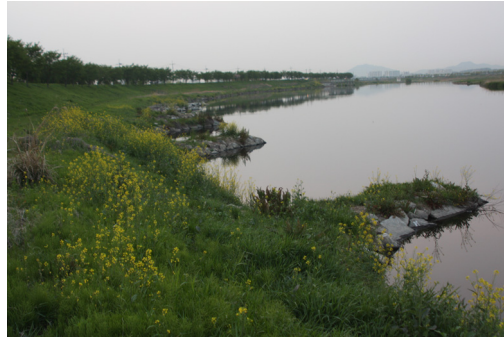
[그림 4-2] 거석을 이용한 돌출수제
