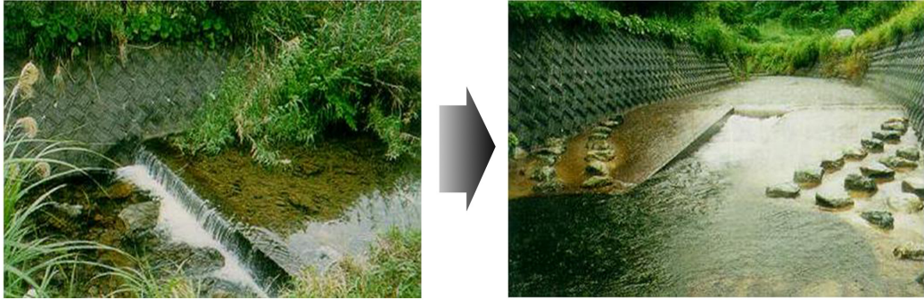
[그림 4-1] 낙차공으로 단절된 하천을 어도의 설치로 연결성 회복
