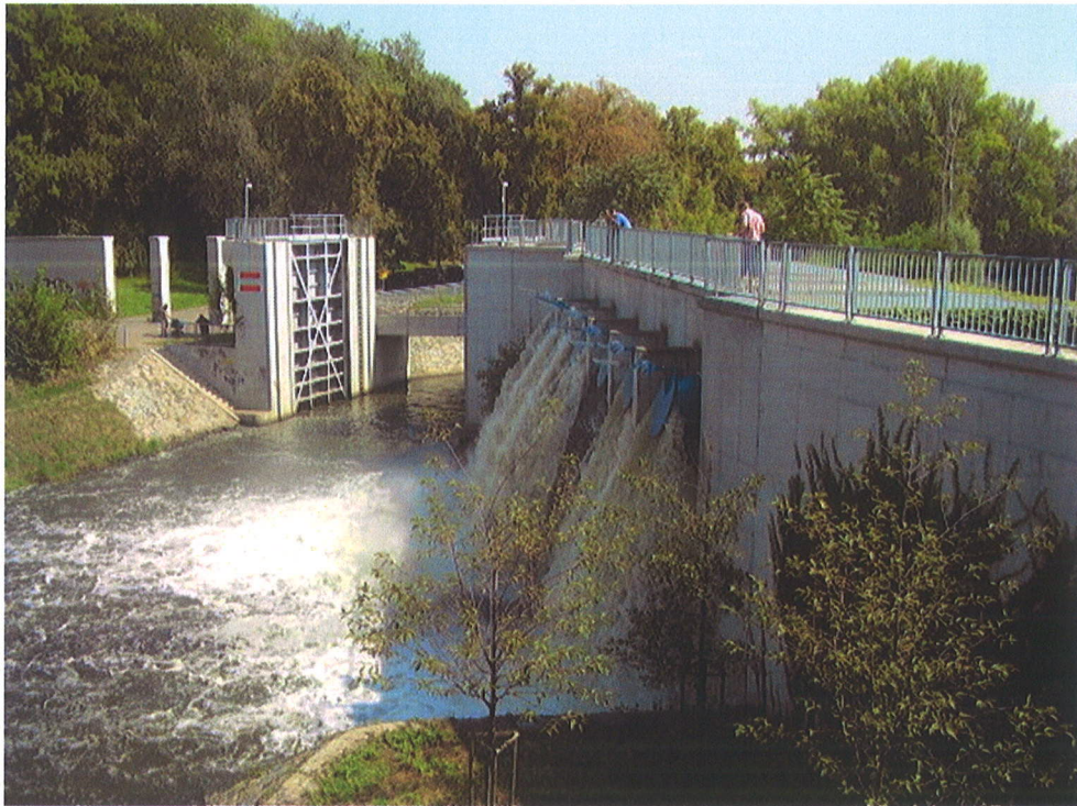
〈그림 6〉 홍수방지용 수문 및 펌프장 설치전경(블타바강 유역관리공사 자료)
