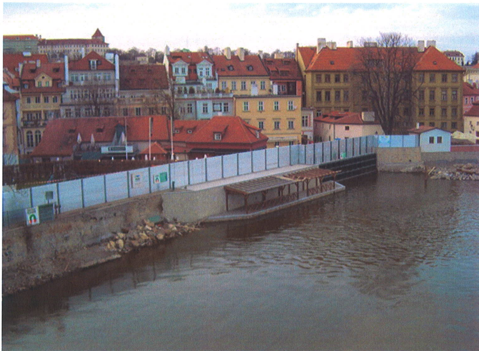
〈그림 5〉 홍수방지용 수문 설치전경(블타바강 유역관리공사 자료)
