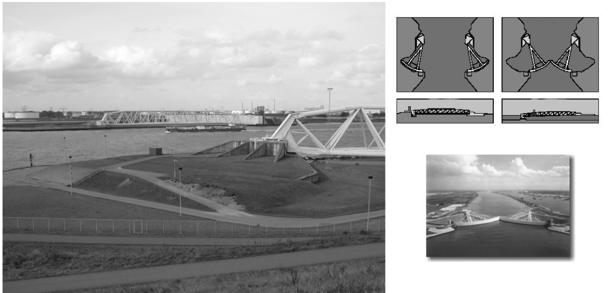
그림 10. 1997년에 완성된 네덜란드 마에스란트케링의 모습. 부채모양의 움직이는 댐이 평시에는 해안에 붙어있다가 해일경보시에 닫히도록 설계되어 있다.
