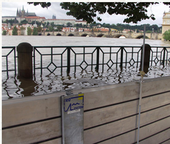
〈사진 1〉 블타바강에 이동식 홍수방어벽이 설치된 전경
