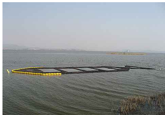
[그림 3-11] 인공식물섬 설치모습(좌 : 대전시 대청호, 우 : 서산시 천수만)
