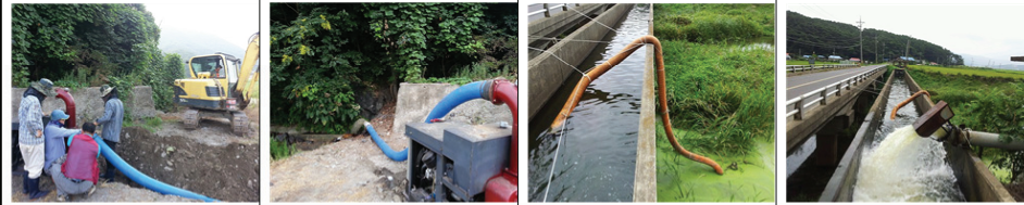
웅천천 굴착 이동양수기 설치 ⇒ 노천뜰 논수로 저류(87HP)
