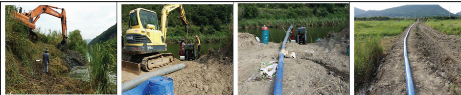
웅천천 하천굴착 이동양수기 1대 추가 설치(132HP 200mm 엔진탐제형) ⇒ 노천뜰 논수로 저류
