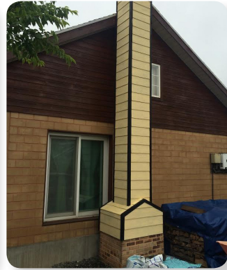
[사진 5] 주택에 설치된 벽난로 굴뚝모습
