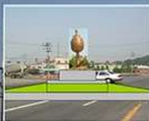
로터리의 전경과 높이 기준 계획안대로 낮춰 시공시 좌대 등의 시야 확보 가능함 (개략적인 크기 및 위치 적용으로 오차 가 있음을 고려할 것: 좌대 상단 1.5m 가량 가장 적당)
