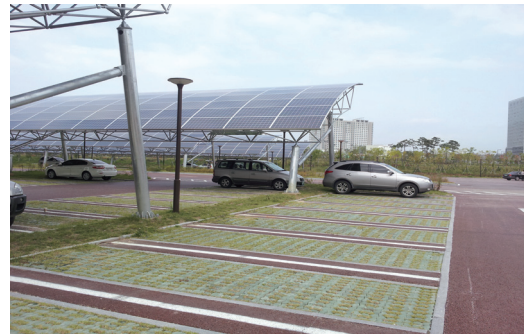
투수성 블록 포장과 태양열 패널로 전기 생산 주차장
