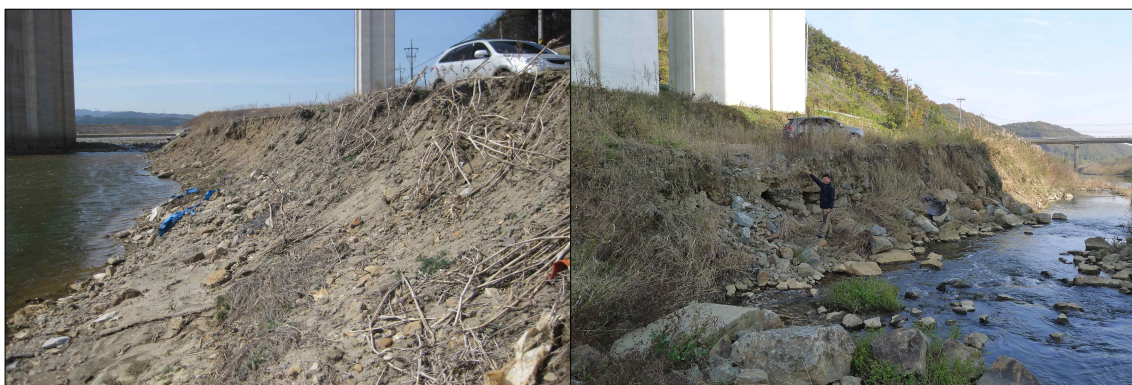
[그림 31] 치성천 가마교 상류 서천-공주 고속도로 교각 인근 침식 현황 (좌:2013, 우:2014)
