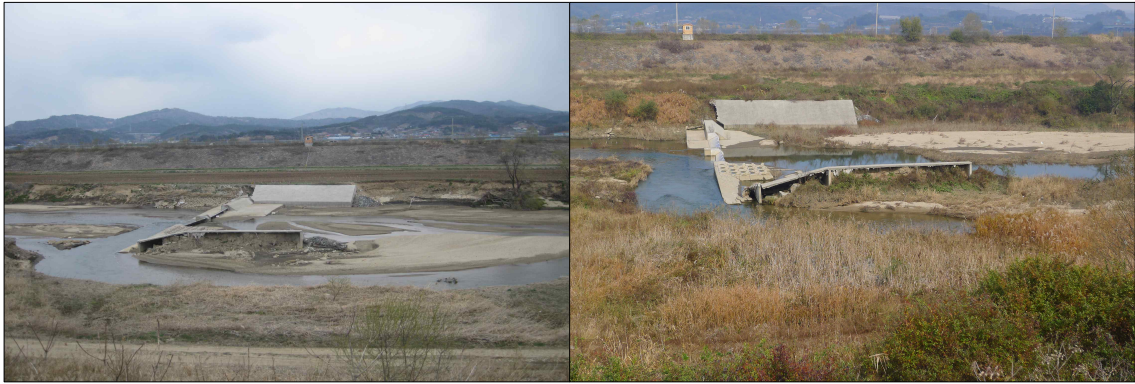
[그림 32] 유구천 침식으로 인한 보 붕괴 유지 현황 (좌:2013, 우:2014)
