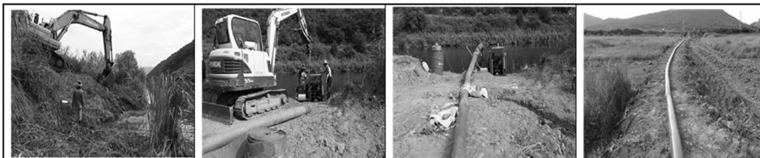
웅천천 하천굴착 이동양수기 1대 추가 설치(132HP 200mm 엔진탐제형) ⇒ 노천뜰 논수로 저류
