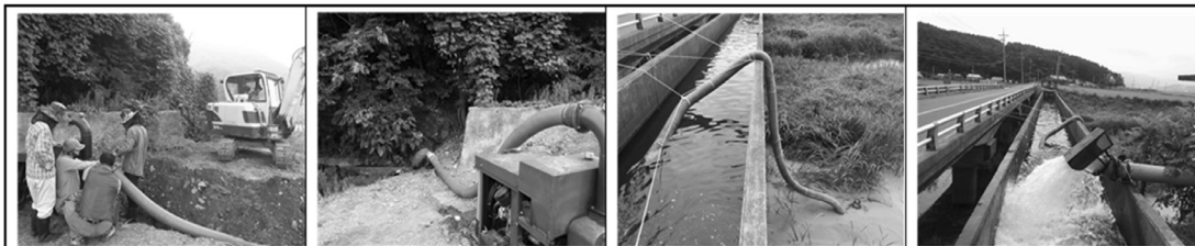
웅천천 굴착 이동양수기 설치 ⇒ 노천뜰 논수로 저류(87HP) 대천3호배수간선 수중펌프 설치 ⇒ 주포용수간선 저류
