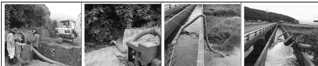
웅천천 굴착 이동양수기 설치 ⇒ 노천뜰 논수로 저류(87HP) 대천3호배수간선 수중펌프 설치 ⇒ 주포용수간선 저류
