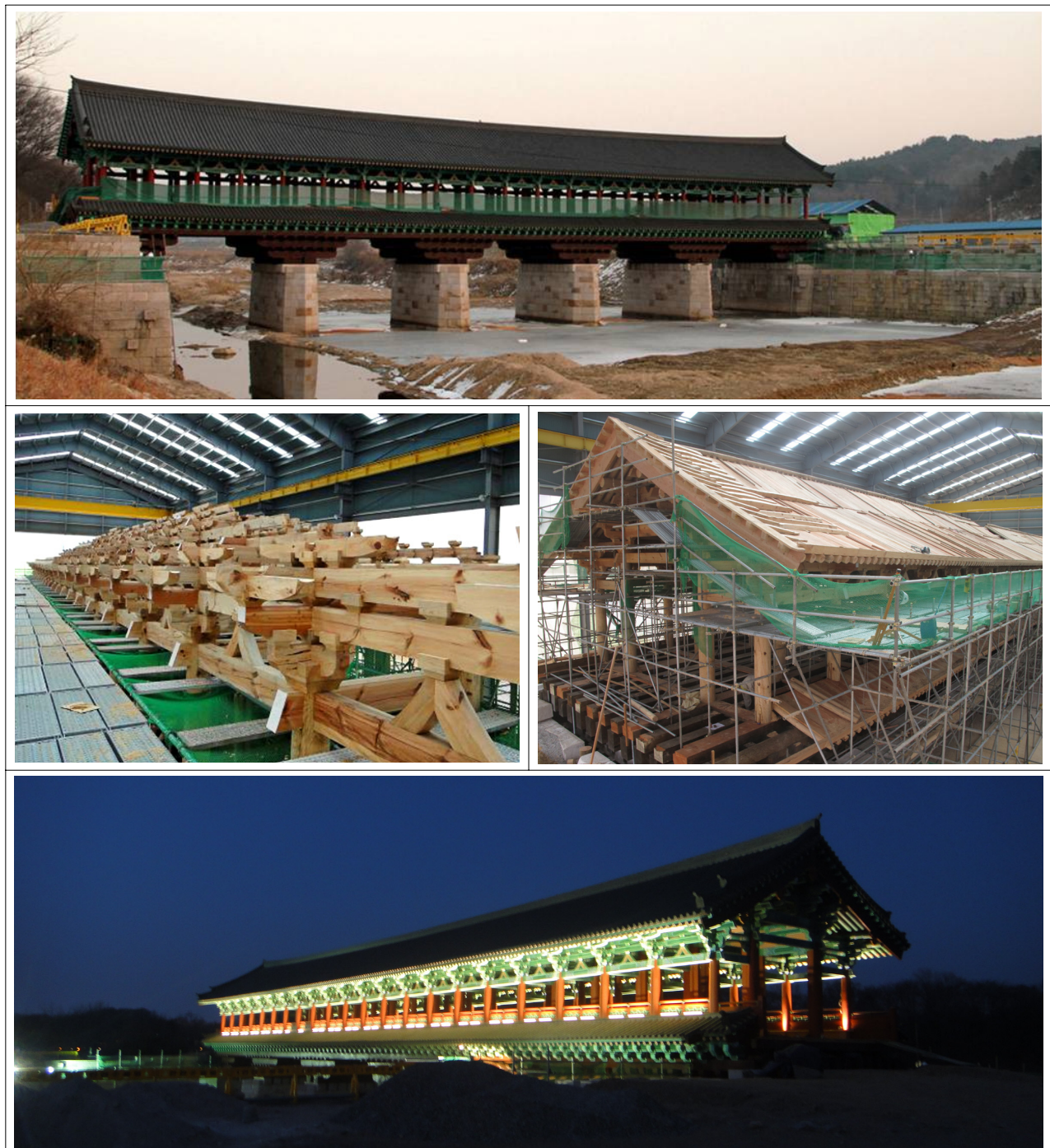
[그림 II-22] 월정교 복원 중, 포작 및 지붕공사, 야간경관조명 시연 모습
