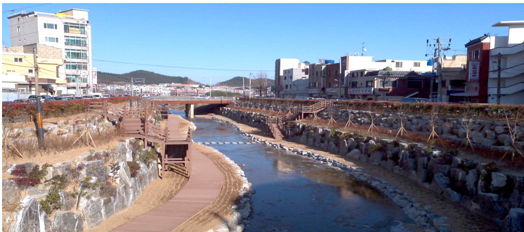
[그림 2-3-11] 과도한 자연석으로 조성된 저수호안의 모습(울산 무거천)
