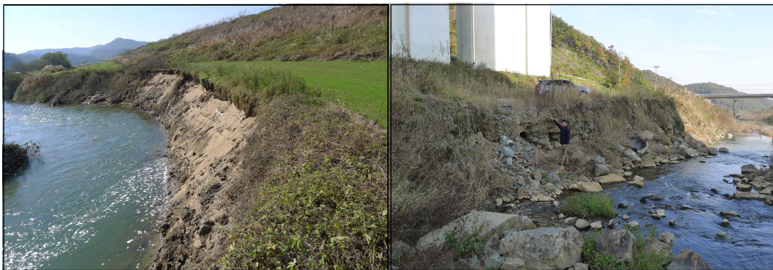
[그림 2-2-45] 지류하천 역행침식 발생현황(좌: 지천, 우:치성천)
