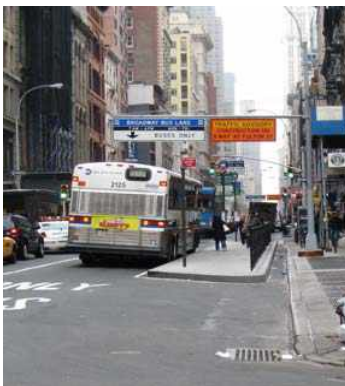
[그림 VI-11] 벌브형 버스베이 설치 사례
