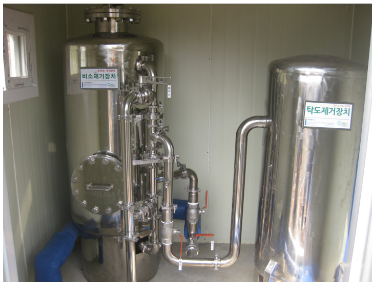
[ 그림 4-4 ] 탁도 및 비소제거용 흡착장치
