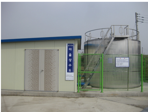
[ 그림 5-3 ] 라인가압을 이용한 소규모수도시설 설치사례
