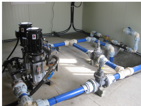
[ 그림 5-3 ] 라인가압을 이용한 소규모수도시설 설치사례
