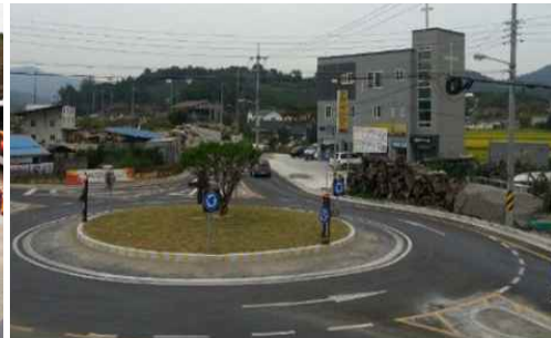
[그림 4-30] 소도로 회전교차로 설치 사례
