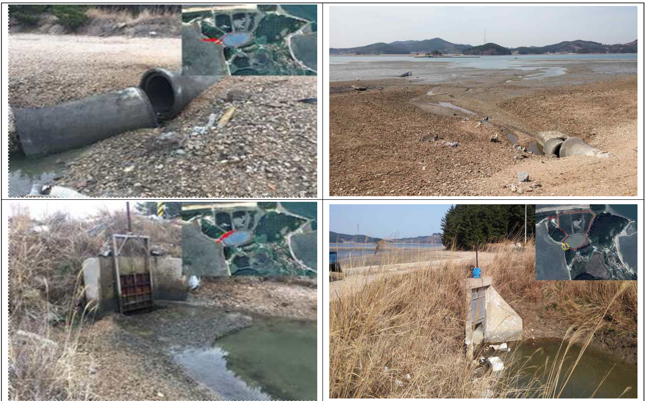
[그림 3-15] 고파도 북측 폐염전(폐양어장) 남측 제방 내·외측 수문 및 해수유입구
