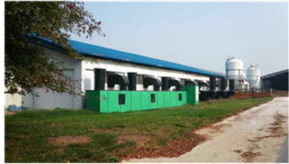
[그림 7.3] 돈사 외부에 미생물을 이용한 바이오필터 시설(출처 : 축산악취 관리 지침서(2016))
