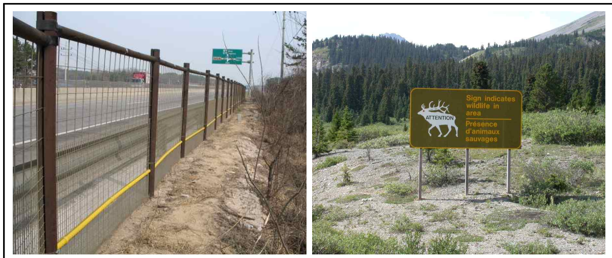
[그림 13] 야생동물교통사고 저감 시설물(좌:침입방지 울타리, 우:동물출현 경고판)
