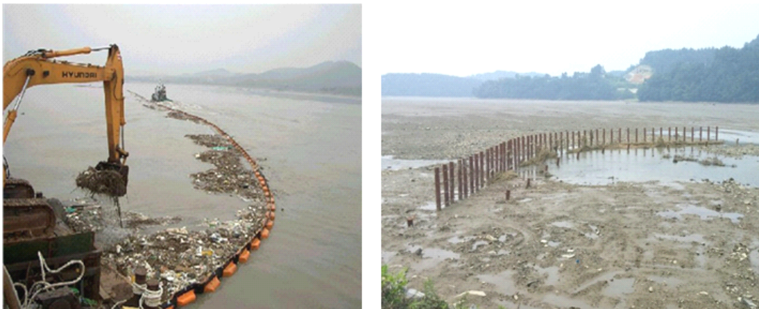
[그림 7-9] 하천 하구 쓰레기 차단막 설치 사례(좌: 인천, 우: 경남)
