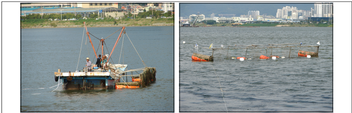
[그림 4-44] 낙동강 부유쓰레기 포집망 설치 모습(국토해양부, 2008)
