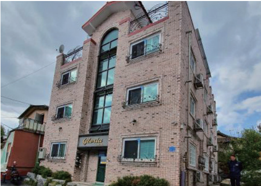
침입범죄 예방을 위해 주 보행로와 접해있는 곳은 방범용 망창, 골목에 접해 있는 곳은 방범용 창살 설치
