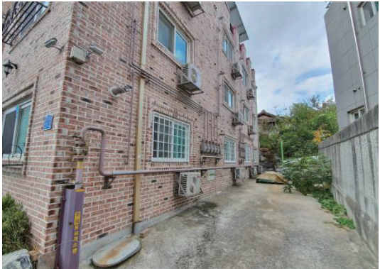
침입범죄 예방을 위해 주 보행로와 접해있는 곳은 방범용 망창, 골목에 접해 있는 곳은 방범용 창살 설치
