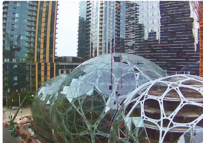
▲ [그림 15] 스피어스에 유리를 부착하는 장면 20)
