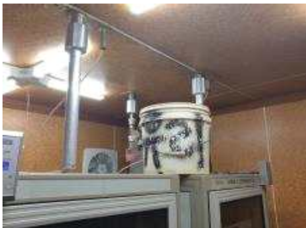
측정소 내부 누수현상 발생 모습
