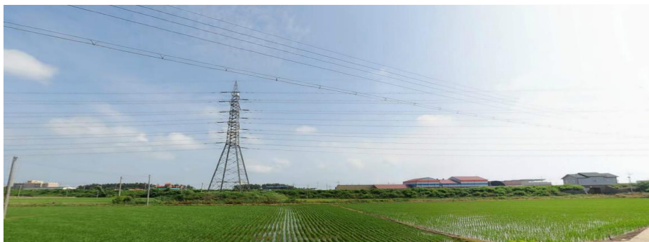
서면 동리마을 앞 송전탑·선로(17호기) 지반고가 낮아 영농장비 이동시 안전 위험
