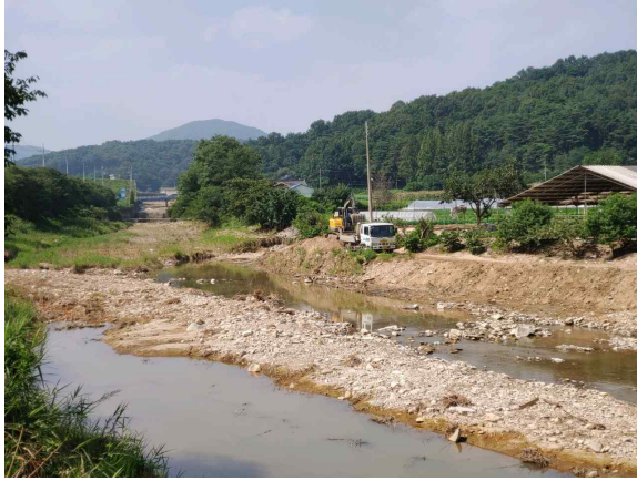
목천읍 서흥1리 산방천 제방 유실 (2020.8.3)
