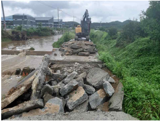
목천읍 천정2리 승천천 제방 및 농로 유실 (2020.8.3)
