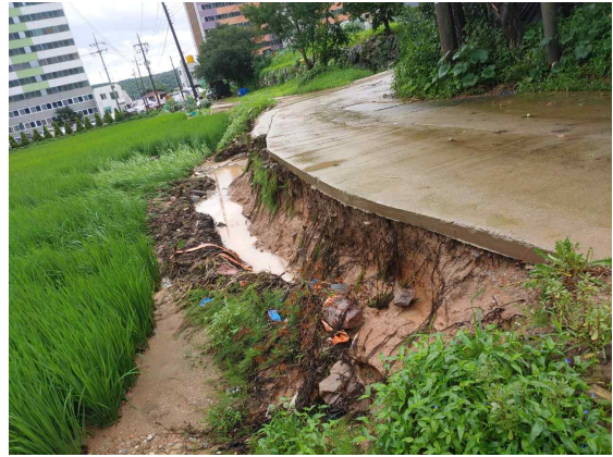
목천읍 서리 제방 유실(2020.8.3)
