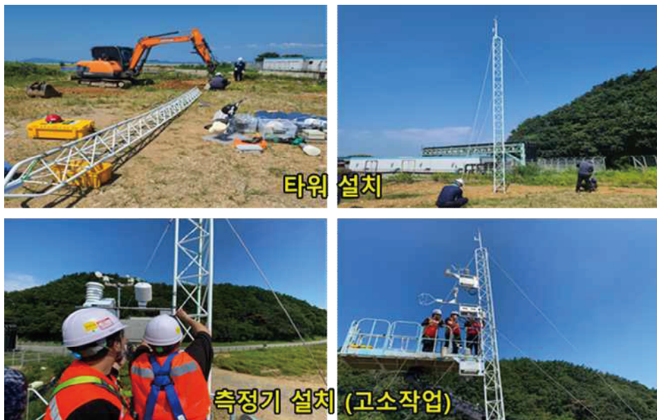
[그림 4.38] 당진화력 회처리장 타워설치 및 측정기 설치 현장 사진
