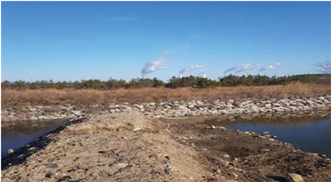
[그림 3.10] 태안화력발전소 주변 하천내 설치된 흙보(하천 내 여러 곳 있음)
