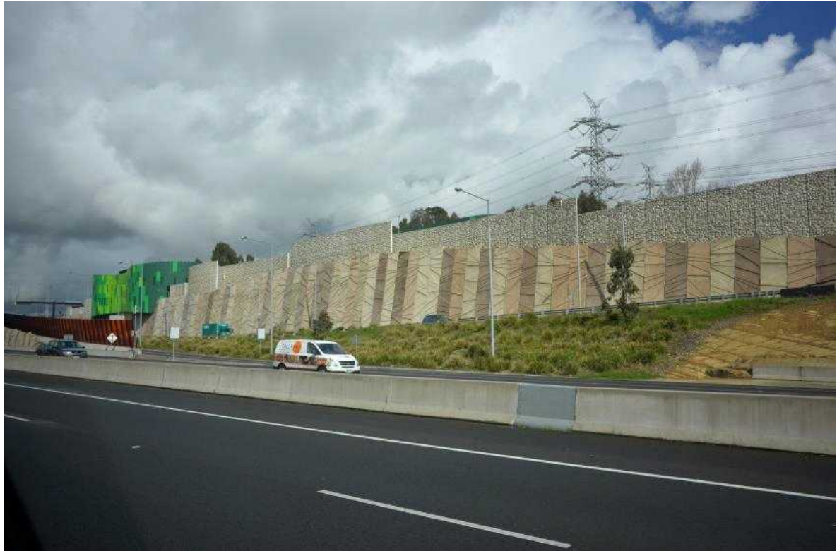
[그림 21] 이스트링크 노선에 설치된 디자인 방음벽 및 법면
