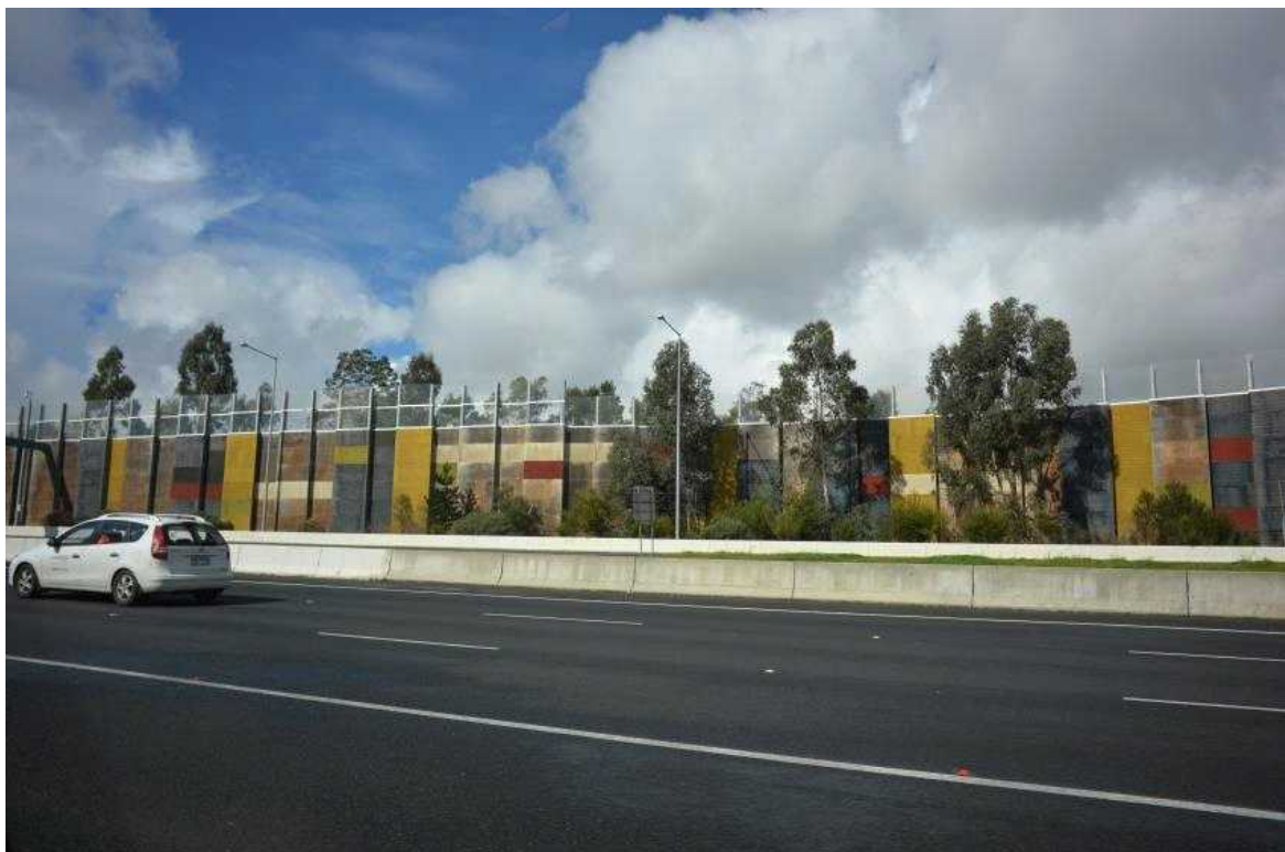
[그림 18] 이스트링크 노선에 설치된 디자인 방음벽 및 식재
